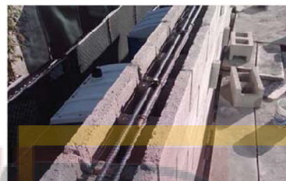
قراردادن میلگرد آجدار به صورت افقی در داخل بلوک‌های بدون جان
