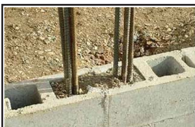
قراردادن میلگرد قائم در داخل حفره‌های بلوک و پر کردن حفره با دوغاب
