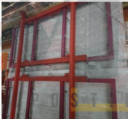
شکل ۱۱-۱۳- نمونه‌هایی از لایه پیوندی و مهارهای انعطاف‌پذیر
