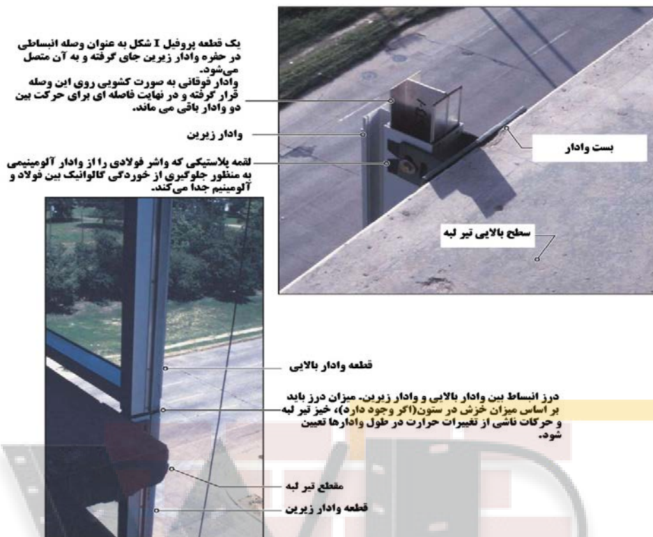
شکل ۹-۷- نمونه اتصال انبساطی بین دو قطعه وادار
