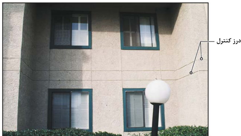
شکل ۶-۲- نمونه درزهای کنترل بر روی نمای سیمانی
