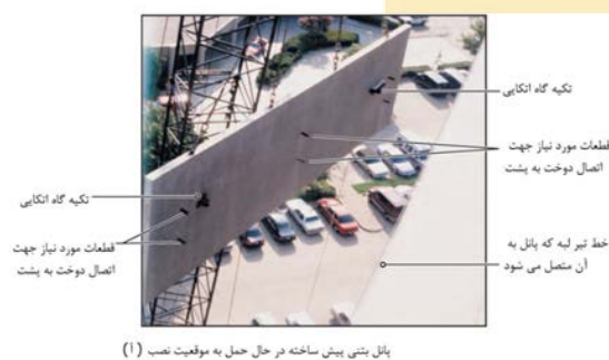
پانل بتنی پیش ساخته در حال حمل به موقعیت نصب (۱)
