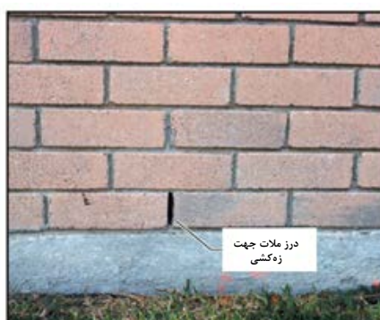
شکل ۵-۱۳- خالی گذاشتن درز ملات جهت زه‌کشی
