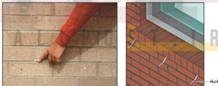
شکل ۵-۱۵- فتیله‌های از جنس طناب‌های پنبه‌ای جهت حفره‌های زه‌کشی
