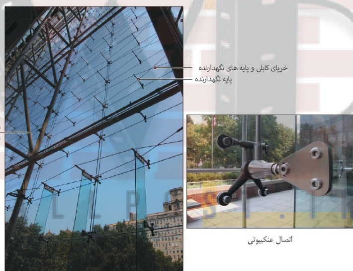
شکل ۹-۱۸- جزئیات نمای پرده‌ای شیشه‌ای با شیشه نصب شده از داخل
