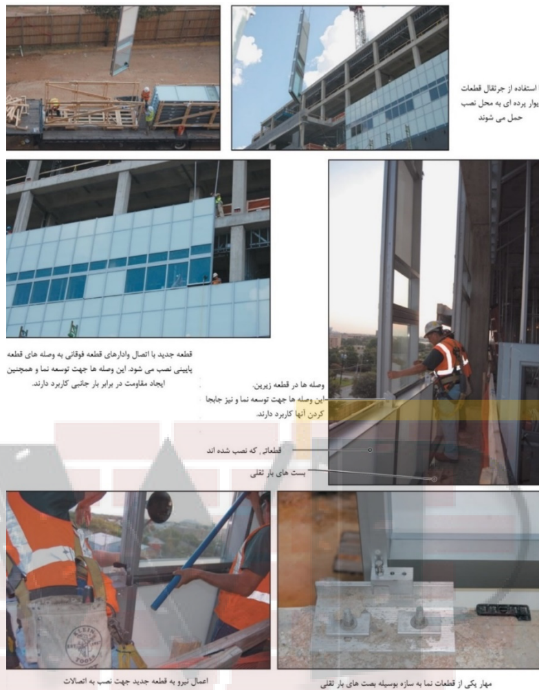
شکل ۹-۱۲- مراحل نصب نمای پرده‌ای یکپارچه
