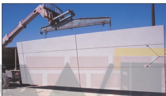
شکل ۱۱-۱۲- الف- سطح بیرونی یک پانل GFRC، در حال حمل در کارگاه
